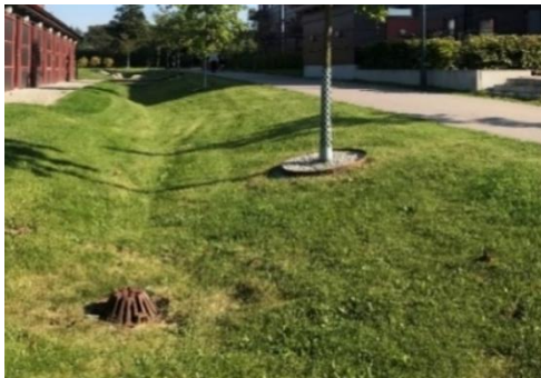
Figur 6. Exempel och principskiss på infiltrationsdike. Foto Structor Uppsala AB samt greenworkspc.com (2018-01-18). Principskiss av WRS (2017).
