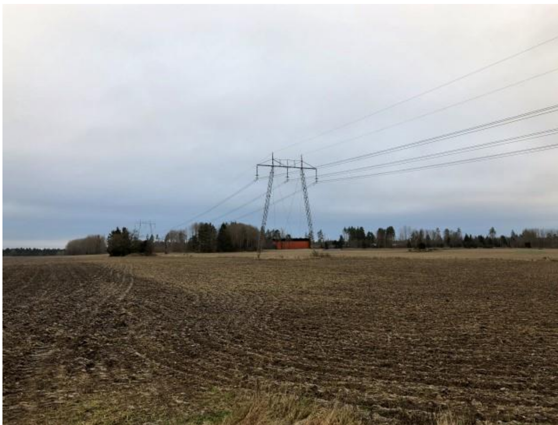
Vy 3. Fotomontage över tänkt exploatering med vy från väg 273 efter planens genomförande. Norconsult 2020.
