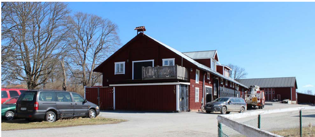
Söder om den gamla bygatan ligger denna timrade f.d. stallänga från 1900-talets början. Stallet har senare byggts om och södra långsidan har försetts med stora garageportar. På gavelnocken finns den gamla vällingklockan kvar som förr ringde till arbete och rast.
