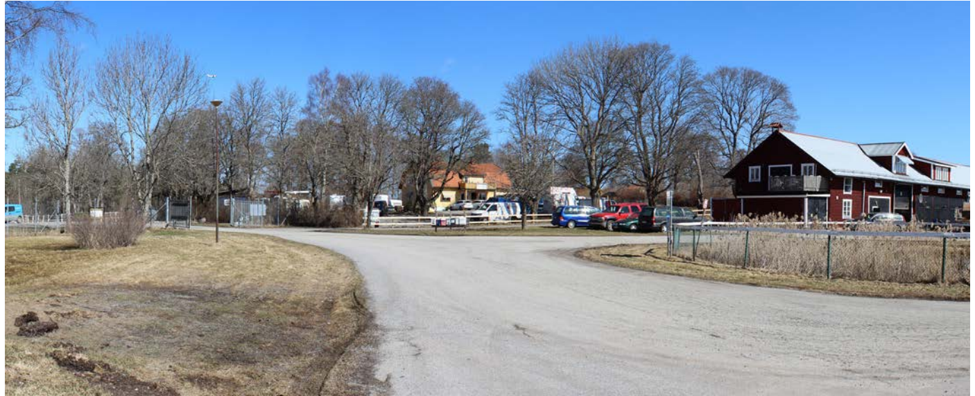
Vid Trosta har den gamla gårdsmiljö integrerats i verksamhetsområdet. Genom området löper den gamla trädkantade bygatan.
