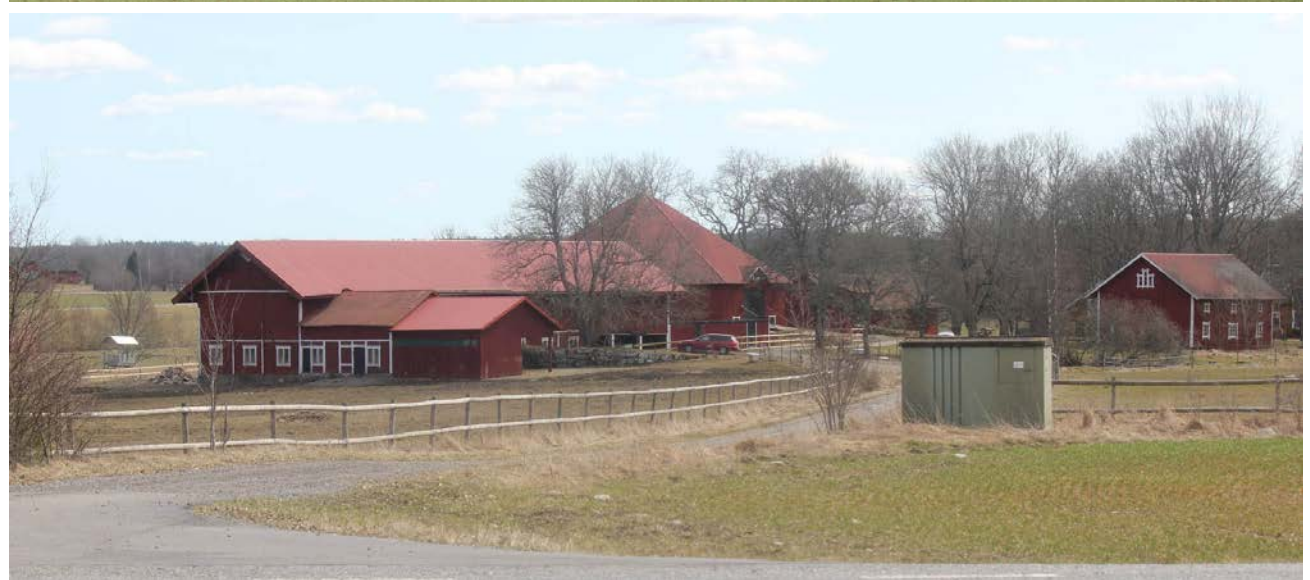
Överst ses en bild av den stora ladugården i tegel vid Skattmansö herrgård, Vittinge socken. Det är ett typiskt exempel på de stora stenladugårdar som började uppföras under slutet av 1800-talet. Nedre bilden visar äldre välbevarade ekonomibyggnader i Ångeby, strax öster om Trosta, beläget inom riksintresseområdet. Förutom ladugård i trä ses här även en åttkantig rundloge.
