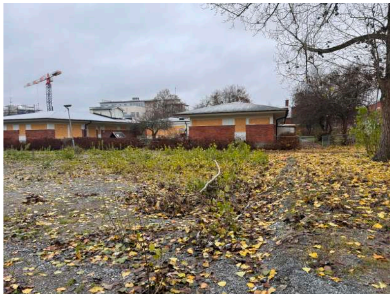
Bild 3: Schaktkanten efter den bort schaktade parkering 3,2 m från poppelns stamfot med tydlig rotskott och mindre vindfällna grenar.
